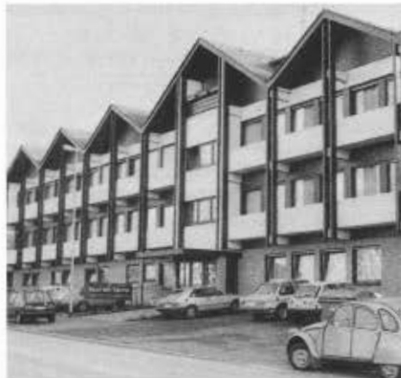
Das Bundesleistungszentrum/Olympiastützpunkt in Mülheim an der Ruhr. Im abgebildeten Haus des Sports sind optimale Möglichkeiten zur Kaderschulung. Gleichzeitig befinden sich hier die Geschäftsstellen vom DBV und BLV-NRW.
